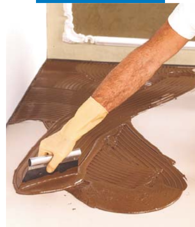
Roztírání lepicího tmelu zubovou stěrkou určenou pro dřevo
